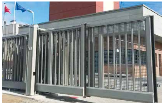
Teleskop-Schiebetore sind platzsparend im industriellen...
